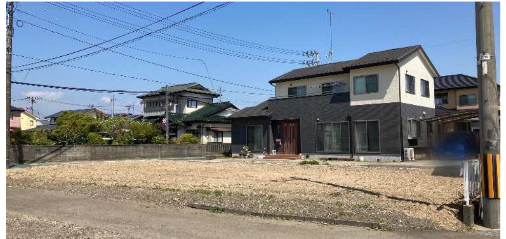
南東側から撮影
