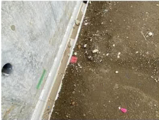
新しく造成工事を行ったお土地の為、境界標もしっかり設置されています。
